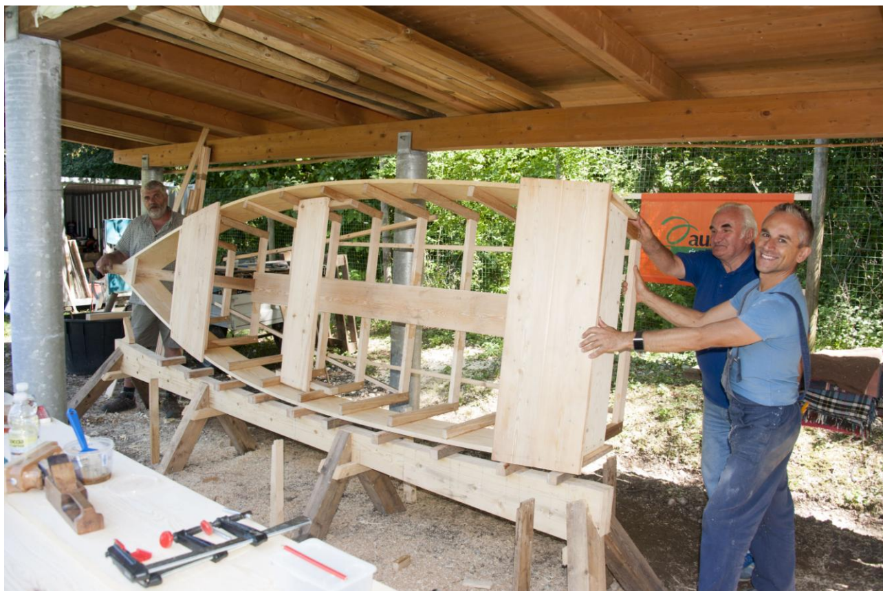
Un momento cruciale, quello del rovesciamento dello scafo
