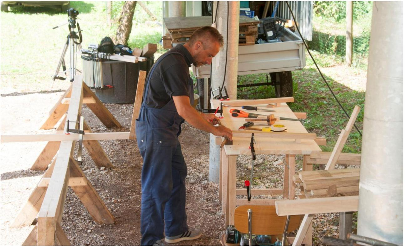
Posizionamento dell'ossatura della barca realizzata in legno d'olmo
